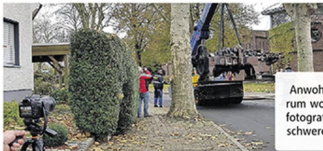
Über Stahlplatten musste das Kranfahrzeug den Stellplatz für die Kettenbiegemaschine anfahren.
