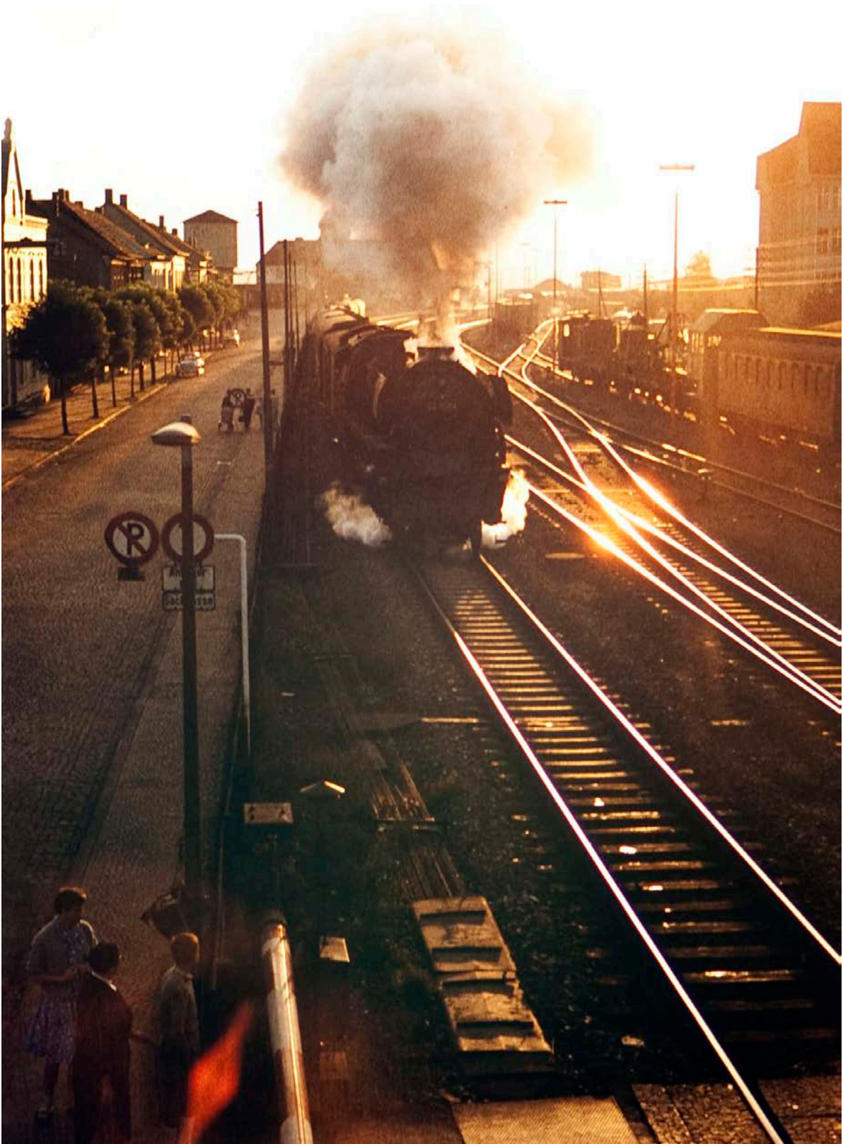
Blick aus dem Stellwerk am Bahnübergang links die Bahnhofstraße, im Hintergrund der Bahnhof mit dem Wasserturm, rechts das Gebäude der Union
