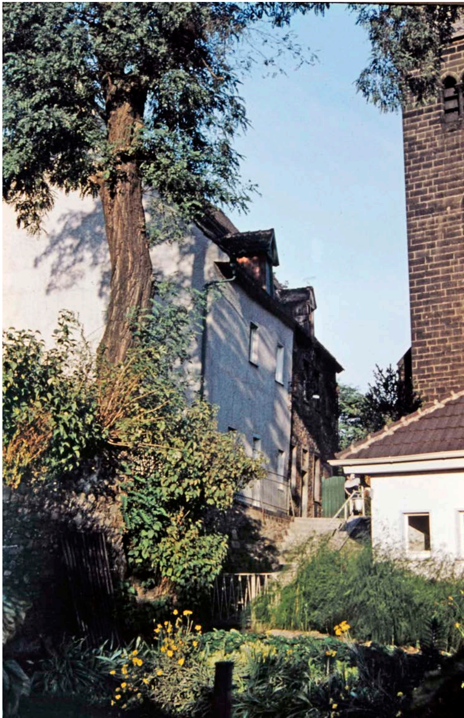
Die selben Häuser im Sommer 1961. Vorn das Haus Zweihoff und dahinter das Haus Eichengrün.
