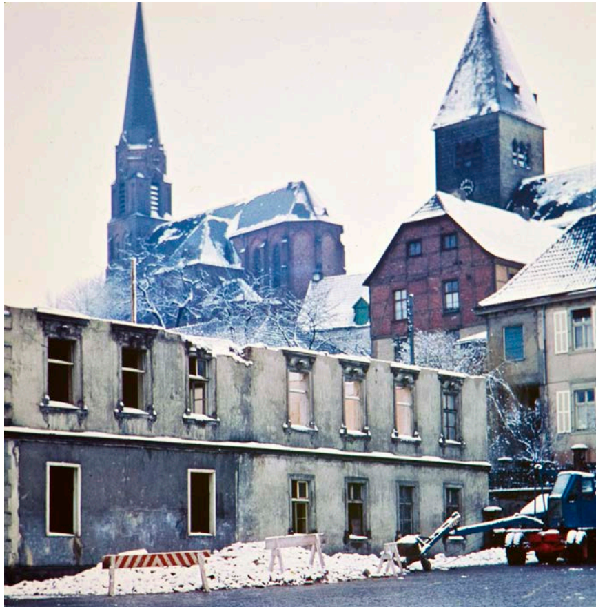
1960 wird am Himmelmannplatz das Haus Neufeld abgebrochen
